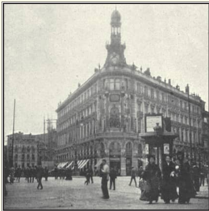
Edificio de La Equitativa, sede del Casino de Madrid entre 1891 y 1910. Construido por José Grases. 1908.
