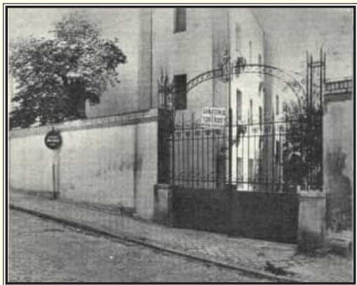
Vista de la entrada de servicios del Sanatorio de Toreros, situado en la madrileña calle de Bocángel.
