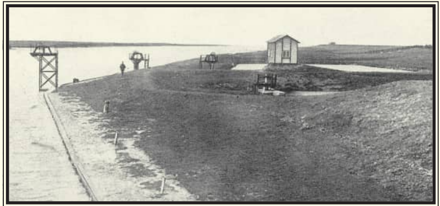
Vista parcial de la instalación con la esclusa y la casa de máquinas. Abajo, vista del dique y de las esclusas en diversas alturas, para hacer pasar el agua del mar de un estanque a otro.
