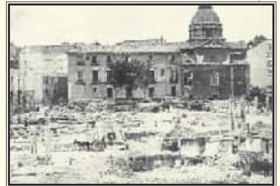
Derribo del Colegio de la Presentación en la antigua calle de la Reina.
