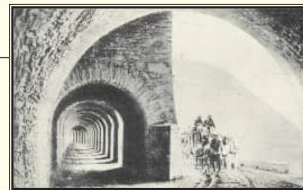
Abajo, a la izquierda, un alud compacto. Sobre estas líneas galería construida para protegerse de los aludes.
