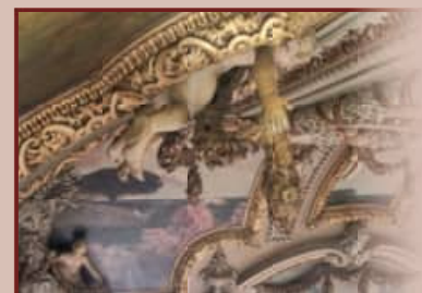
Sobre estas líneas, tres detalles de las labores de limpieza llevadas a cabo en el Salón Real.
