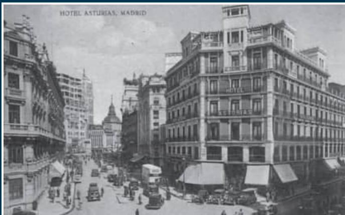
Bajo estas líneas, derribo del Palacio del Marqués de Santiago y posterior edificación del Hotel Asturias. Arriba, en la Plaza de Santa Ana, edificio donde se situaba el Café de Sólito.
