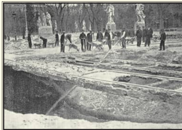
Obreros trabajando en la recomposición del trozo hundido en la Plaza de Oriente.
