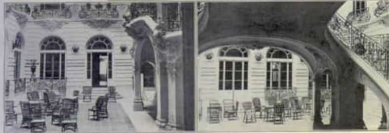
Escalera principal.—Vista.—Escalera de honor. EL NUEVO EDIFICIO DEL CASINO DE MADRID.
