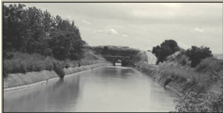
Canal principal de Aragón y Cataluña. Abajo, a la izquierda, sifón del río Sosa.
