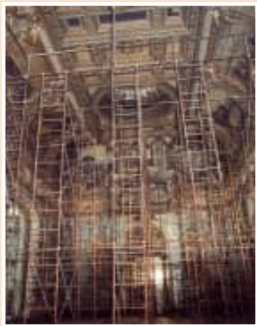
Andamios instalados en el Salón Real en la rehabilitación del edificio.
