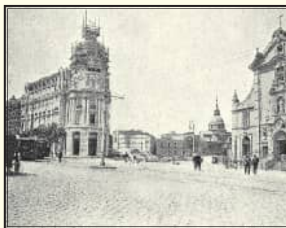
Entrada de la Gran Vía.
