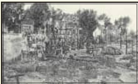
Arriba, ruinas de la sección francesa. Debajo, estado en que quedó la "Bruselas-Kermesse" después del incendio.
