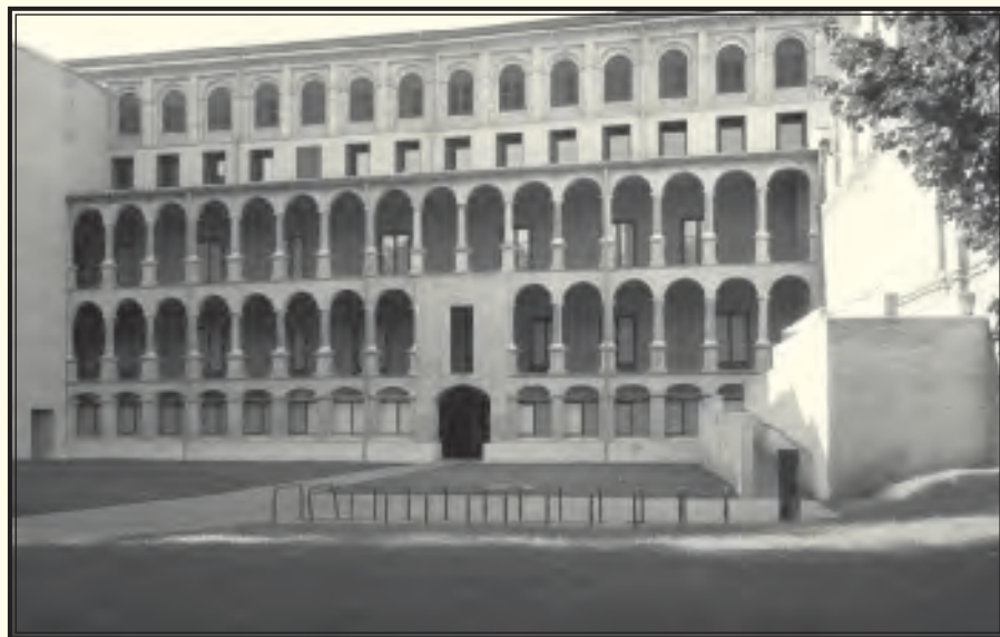
Interior del Palacio de Ezpeleta.
