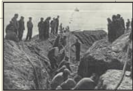
Operación de echar el cable a tierra para conducirlo por una zanja hasta la caseta de amarre.
