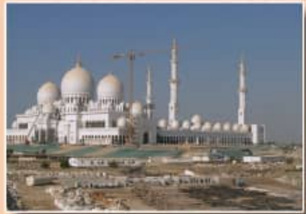
Mezquita Dubaití, en construcción.
