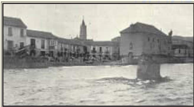
Restos del puente de la Aurora y entrada de la calle de los Mármoles.
