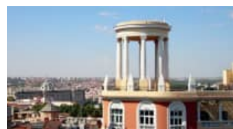
Templete del edificio Juan Miralles y el Palacio de Oriente.
